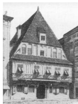
Edificio trecentesco in Stiria, (Bassa Austria), sede di una scuola valdese
